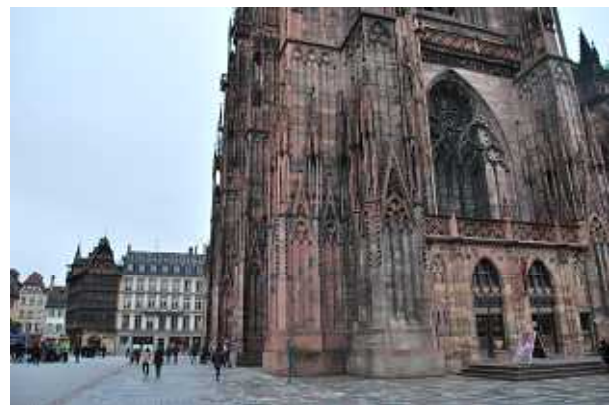
「ノートルダム大聖堂」外観 (ストラスブール市内)
